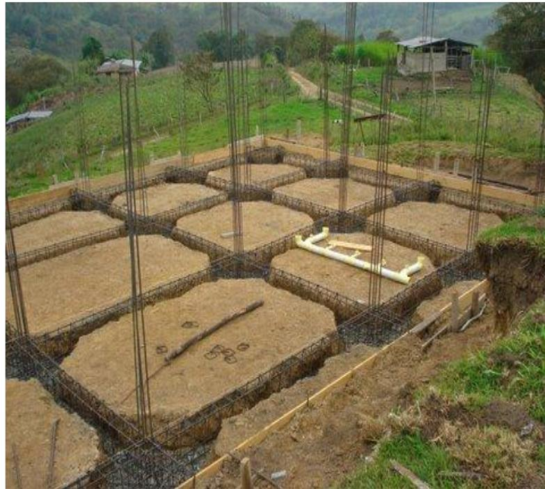
Figura 20. **Losa de Fundación (con vigas de riostra).** *Nota.* Bonucci (2012).
