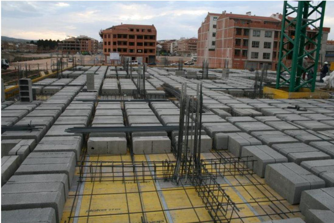
Figura 12. **Encofrado de losa reticular con bloques de concreto (sin vigas).** *Nota.* Datos tomados de <http://www.lavirtu.com/albumes.asp?idcategoria=63986>
