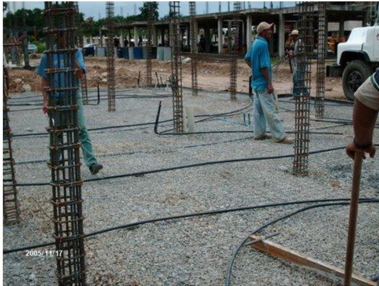
Figura 21. Losa de Fundación (con vigas de riostra). *Nota.* Bonucci (2012).
