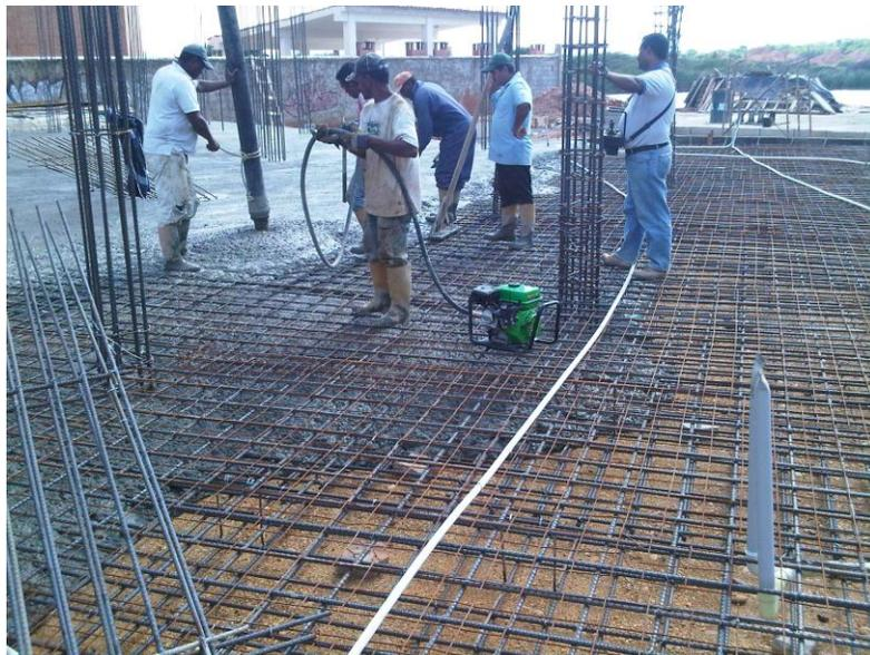
Figura 19. Losa de Fundación (sin vigas de riostra). Nota. Tomada del Ing. Carlos Polanco.
