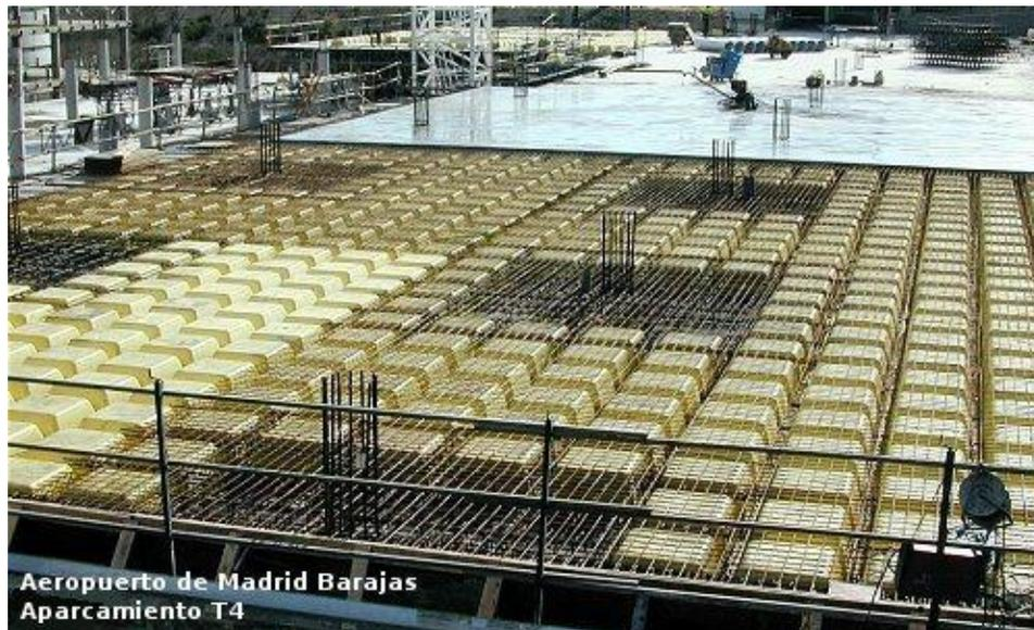
Figura 11. Encofrado de losa reticular con casetones (sin vigas). *Nota.* Datos tomados de <http://www.sevilla21.com/foro/viewtopic.php?f=5&t=5382&start=2600>
