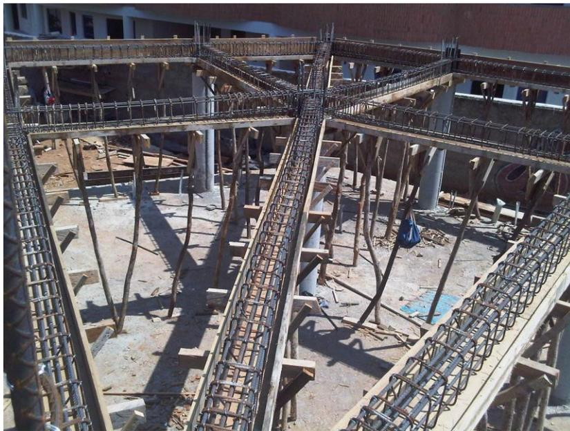
Figura 15. **Acero en viga de carga sobre encofrado.** *Nota.* Datos tomados de Ing. Carlos Polanco
