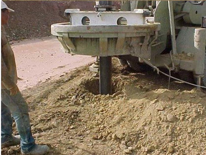
Figura 23. **Ejecución de un pilote vaciado un situ.** (a) máquina de pilotes preparada para empezar a perforar, (b) máquina perforando. *Nota.* Bonucci (2012).
