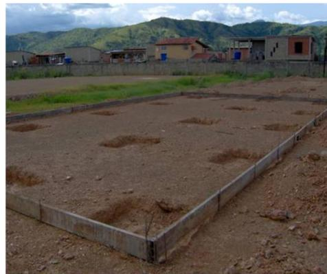
Excavación de zapatas en losa de fundación
