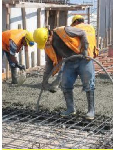
Figura 1. **Vaciado y vibrado de losa maciza.** Nota. Datos tomados de <http://www.lavirtu.com/albumes.asp?idcategoria=63986>
