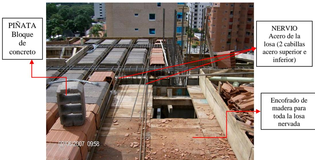
**Figura 3. Armado de planta de Envigado de entrepiso Losa nervada en una dirección (Edificio de apartamentos). Nota. Bonucci (2012).**
