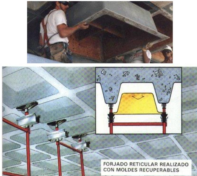
Figura 10. Forma de apuntalamiento y desencofrado de casetones. *Nota.* Datos tomados de <http://concretoarenas.blogspot.com/2011/09/losa-reticular.html>
