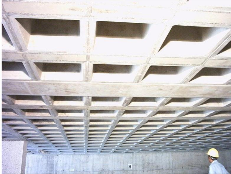
Figura 13. Vista de una losa reticular desencofrada. Nota. Datos tomados de <http://www.estructurasguadalimar.com/es/forjado-bidireccional>
