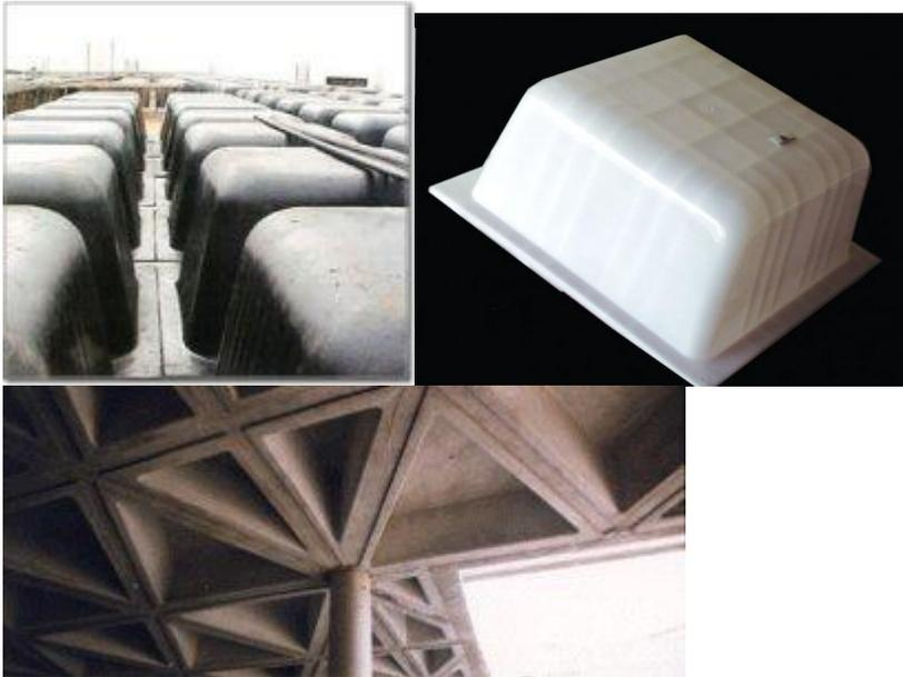
Figura 9. Casetones colocados durante la construcción, casetón plástico y techo desencofrado reticular triangular. *Nota.* Datos tomados de <http://powermaxquito.wordpress.com/2009/10/01/casetones-plasticos/>
