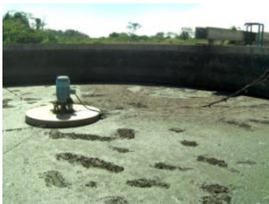
Figura 4.15. Sedimentador de la Planta La Mariposa II. Año 2010
