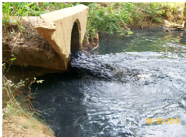
Figura 4.48. Descarga de Lodos Residuales de Sulfato de Aluminio al Embalse Pao Cachinche
