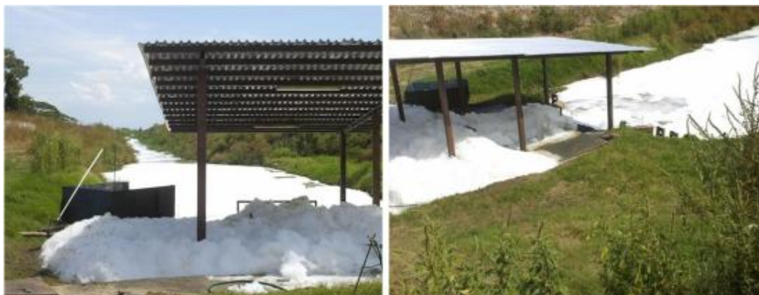
Figura 4.17. Sector Unión Lago de Valencia con Río los Guayos y la salida de la PTAR de los Guayos
