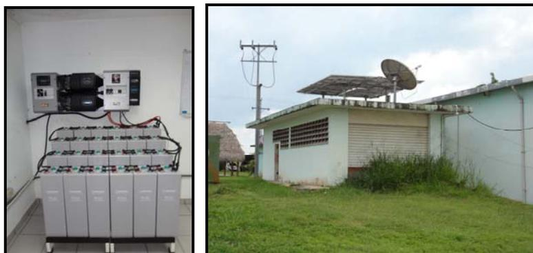
Figura 59. Vista del SFV 3840 Wp. instalado en el CENIT, Base Sucre en el Estado Aragua (a) Panel de control y banco de baterías de gel (b) Arreglos fotovoltaicos.
