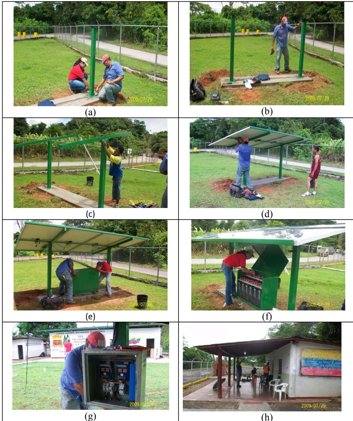
Figura 52. Procedimiento realizado en la instalación del SFV 1200 Wp.
