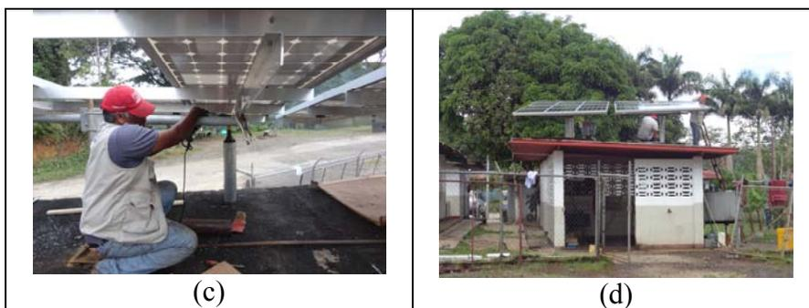
Figura 84. (a) Instalacion de modulos fotovoltaicos en la estructura de soporte, (b) Vista final de los cuatro (04) arreglos fotovoltaicos.
