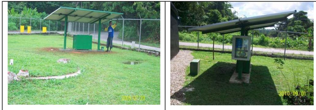
Figura 30. Sistema fotovoltaico de 1200 Wp. Instalado en el puesto militar (Fotografía tomada en Julio 2009).
