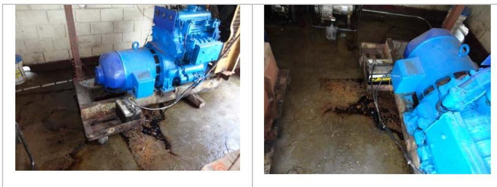
Figura 51. Aceite derramado por el generador (Fotografía tomada en Agosto, 2014).
