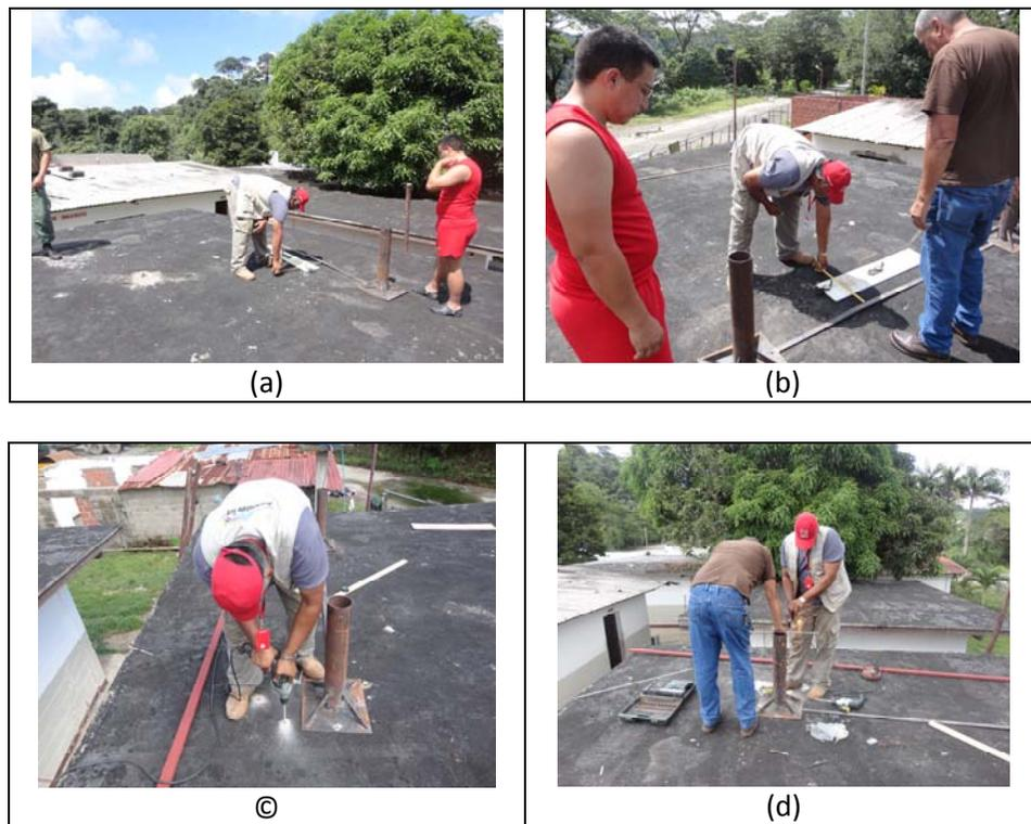
Figura 80. (a) Ubicación del sitio de anclaje, (b) Medición de distancia de separación entre mástil. (c) Perforación de platabanda, (d) Corte de barra roscada para instalar en el mástil y así garantizar su estabilidad.
