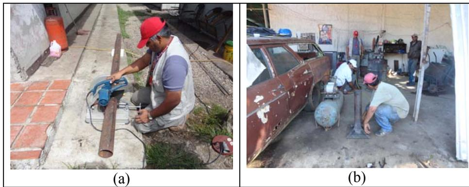
Figura 78. (a) Corte de tubo de 4 pulgadas, (b) Anclaje de 80 cm.
