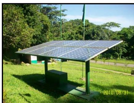
Figura 57. Vista del SFV 1200 Wp. instalado en una estación guarda parques.
