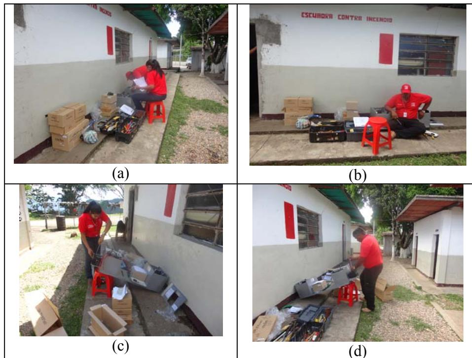
Figura 88. (a) y (d) Desembalaje de los componentes que integral el armario de control, (c) y (d) Instalación de componentes electrónicos y conexiones dentro del armario de control.
