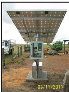
Figura 56. Vista del SFV 600 Wp. instalado en una vivienda.
