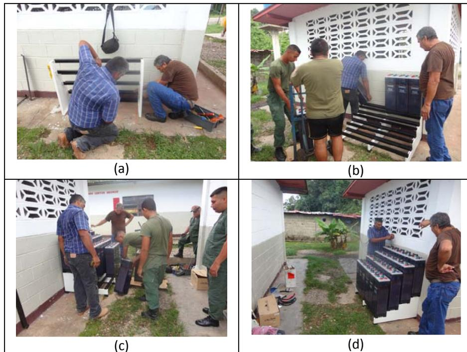
Figura 93. (a) Ensamblaje del armario de las baterias, (b) instalacion de las baterias en el armario, (c) Colocacion del restante de baterias, (d) Vista final del banco de baterias.
