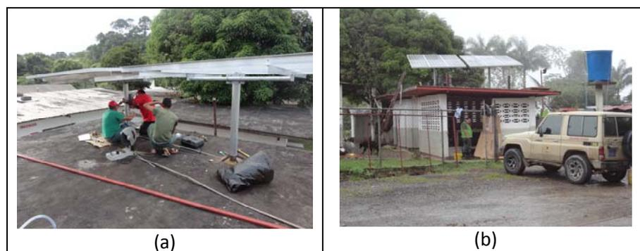
Figura 82. (a) Instalación de estructura de soporte y módulos fotovoltaicos, (b) Vista de cada arreglo fotovoltaico conformado por seis módulos.
