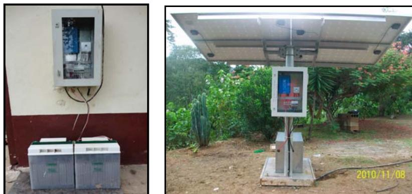
Figura 55. Vista de los componentes del SFV 600 Wp. instalado en una vivienda.
