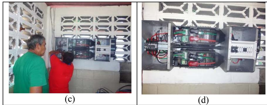
Figura 91. (a) Vista de la caja AC, Inversores y caja DC, (b) y (c) Ajuste de conexiones electricas en la caja AC, (d) Vista final de las conexiones internas del armario.
