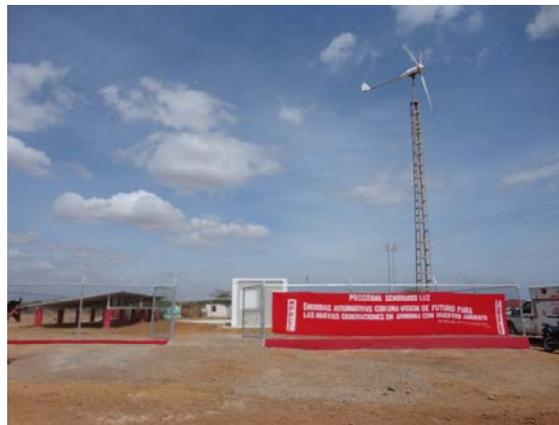
Figura 7. Sistema híbrido instalado en la comunidad Los Arroyos, Estado Falcón (Fuente: Programa Sembrando Luz, Mayo 2012).
