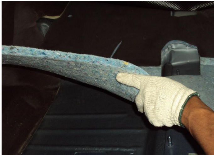
Fig. No. 14 Instalación de alfombra
