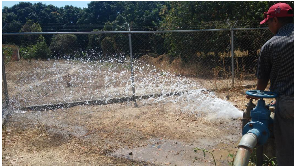
Figura 3. Prueba de descarga del equipo de bombeo.
