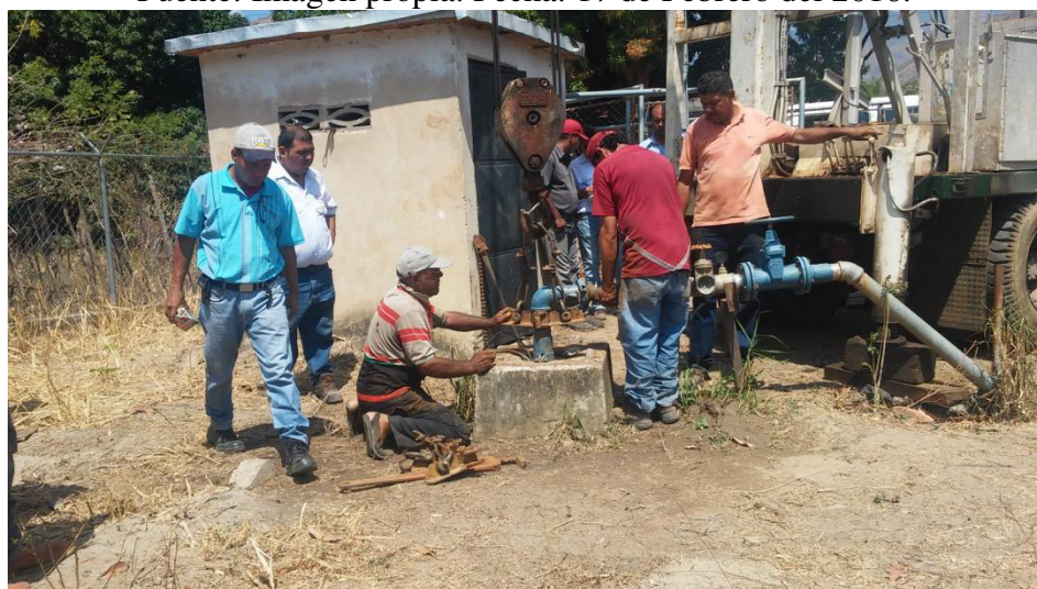
Figura 2. Instalación del manifold del pozo profundo.
