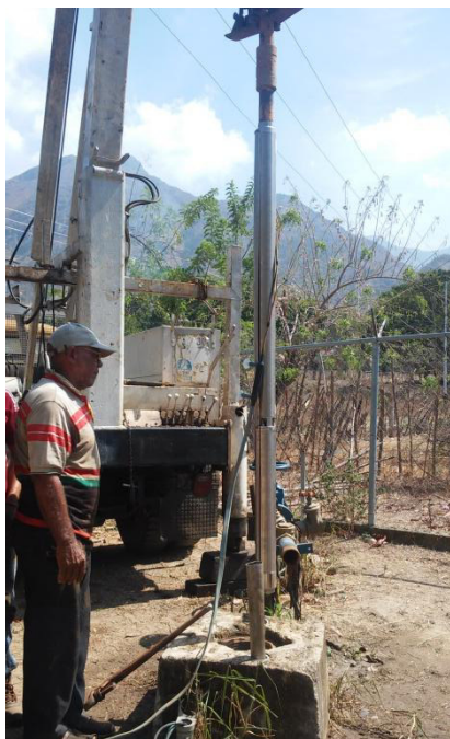
Figura 1. Instalación del equipo de bombeo del sector Brisas del Mayei.
