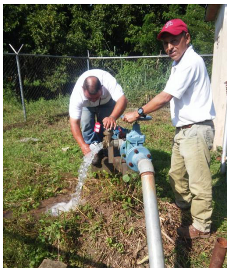
Figura 44. Toma de muestra de agua proveniente del pozo profundo.
