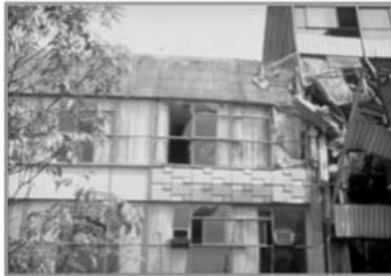
Ilustración 15: Interacción entre edificios de diferente rigidez.
