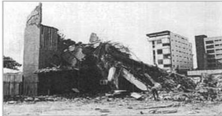
Ilustración 17: Edificio Miramar-Cumana, después del sismo de 1997.
