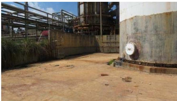
**Figura 6.** Condiciones de las bases de concreto construidas para los tanques de TEP
