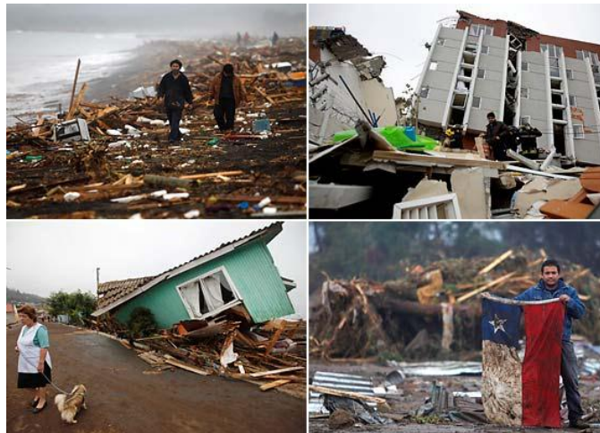
Figura II.4 Daños causados por el terremoto de Chile en el 2010.
