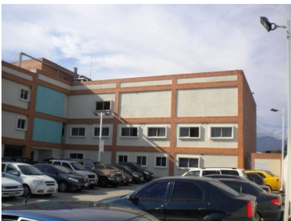
Foto #3: Vista trasera, bloque A. Área del estacionamiento
