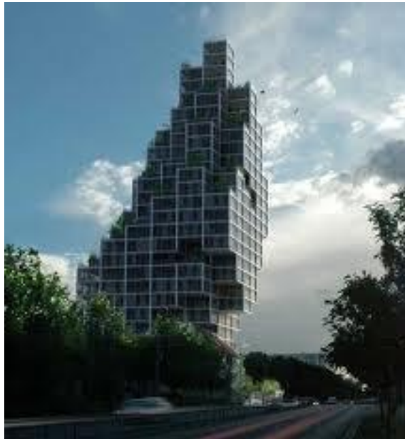
FIG. 2.12 EDIFICIO PRESENTA DISTRIBUCIÓN IRREGULAR DE MASAS (DINAMARCA)
