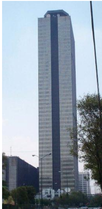
FIG. 2.15 TORRE EJECUTIVA PEMEX (CIUDAD DE MÉXICO), CON UNA ALTURA DE 214 METROS
