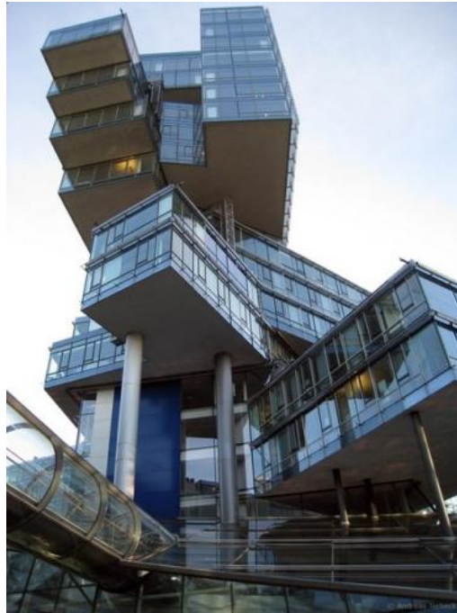
FIG. 2.14 EDIFICIO PRESENTA UNA MARCADA VARIACIÓN EN LA GEOMETRÍA DEL SISTEMA ESTRUCTURAL
