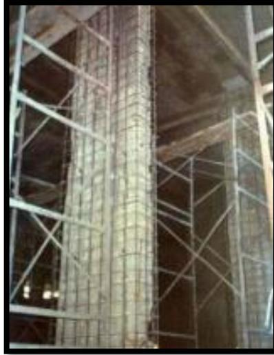
*Fig. 2.9.- Colocación del refuerzo en una columna de una edificación.*
