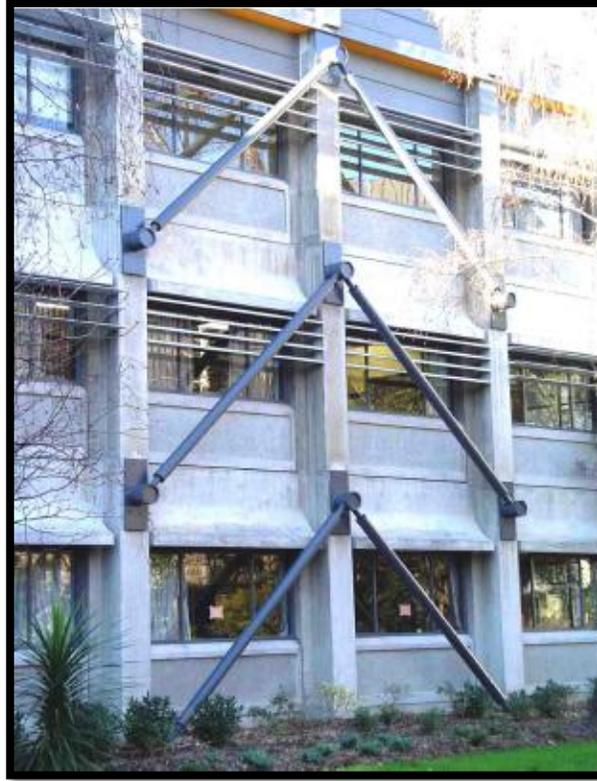
*Fig. 3.16. Ejemplo de rehabilitación mediante el agregado de riostras de acero.*
