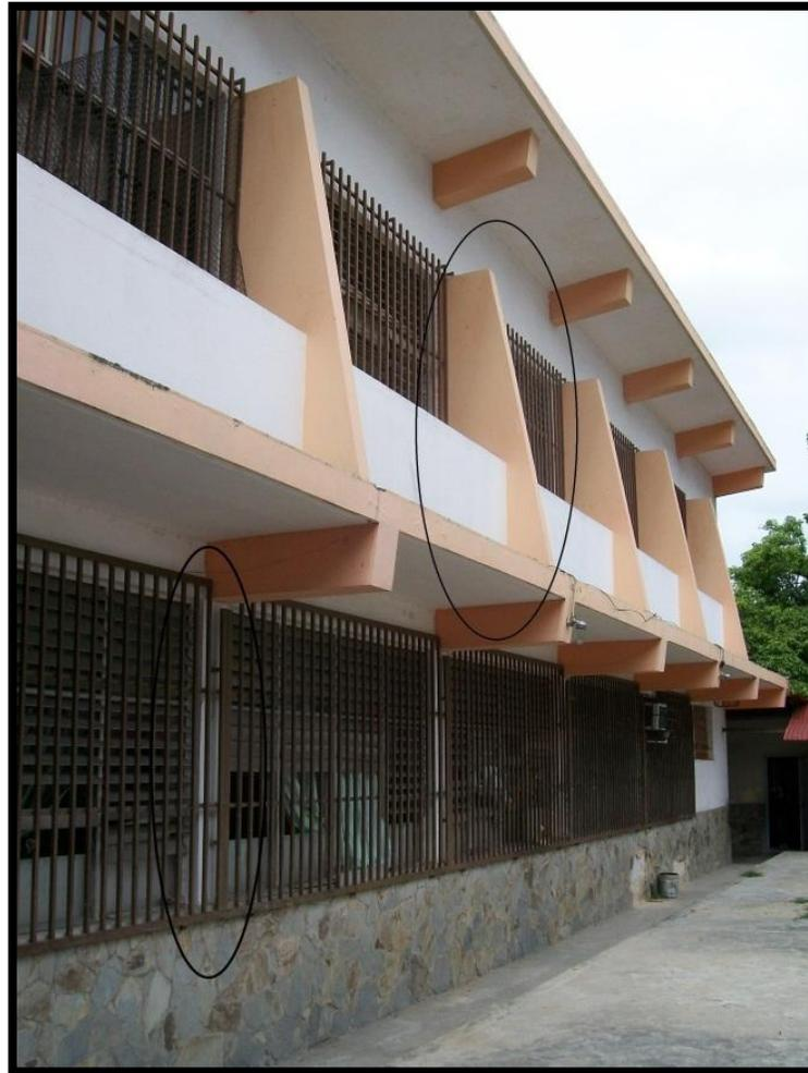
Imagen 3. Ausencia de Mampostería en el eje A entre ejes 3 y 4, nivel uno.
