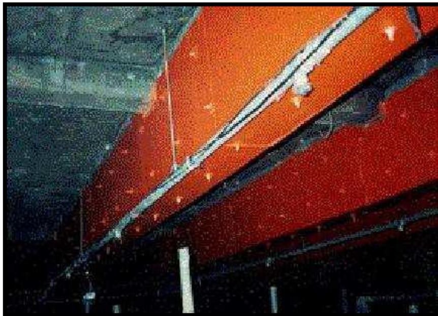
*Fig.2.15.- Planchas de Acero colocadas en vigas.*
