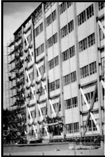
*Fig.2.7.- Refuerzo con Diagonales*
