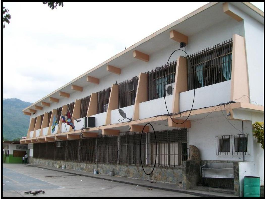
IMAGEN 2. Ubicación de los parasoles y efecto de columna corta, fachada norte.
