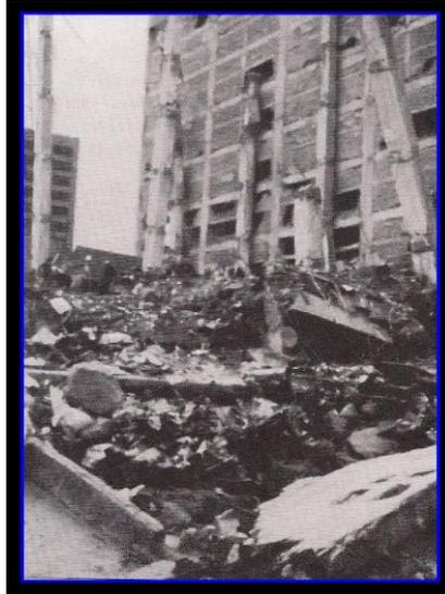
**Figura 27:** Falla de un edificio a base de losas planas por punzonamiento de losas.
