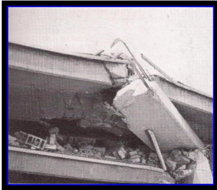
**Figura 26:** Falla por escasez de anclaje del refuerzo de la columna en su conexión con el sistema de piso.
