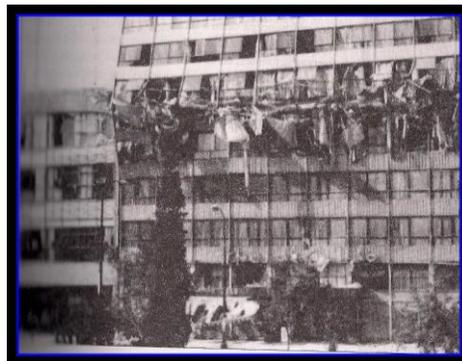
**Figura 31:** Falla debido a golpeo entre edificios adyacentes.
