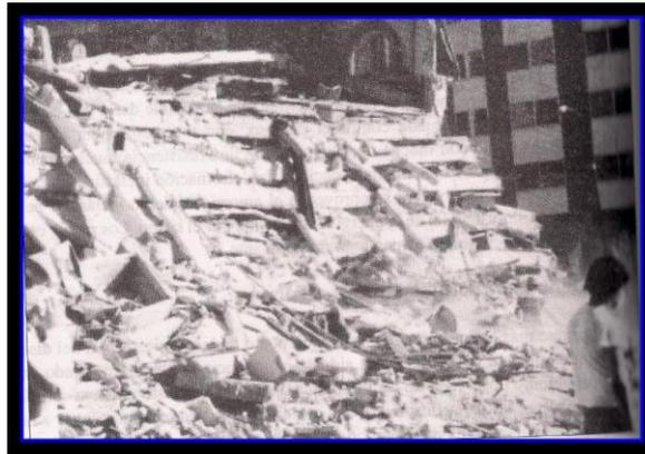
**Figura 24:** Colapso de un edificio por falla de columnas.
