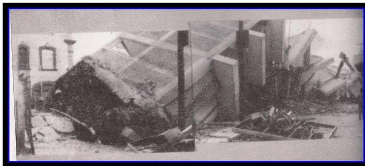
**Figura 28:** Volteo de un edificio por falla de cimentación.
