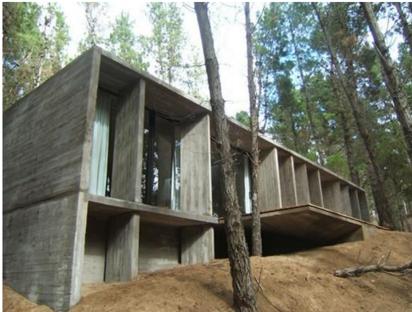
Figura 18: estructura a base de grandes paneles prefabricados
