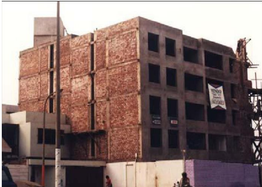
Figura 15: Efecto de torsión en planta, causado por tanque elevado
