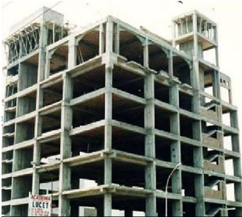
Figura 21: Estructura a base de pórticos de Concreto.
