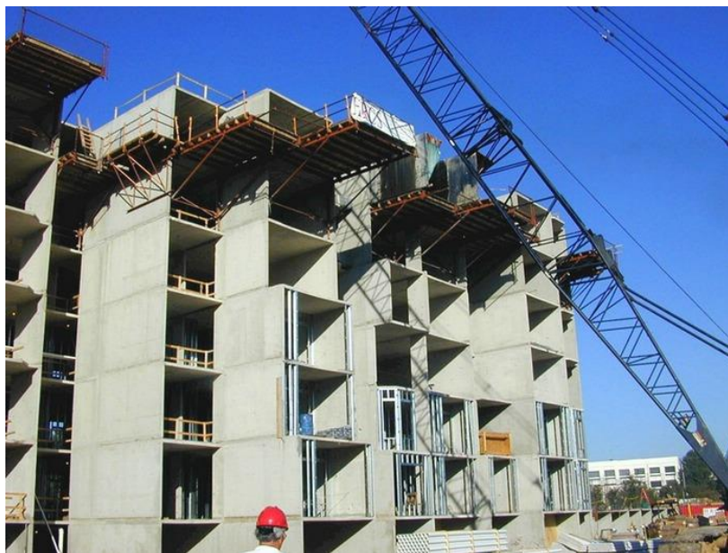
Figura 20: Sistema Constructivo Tipo Túnel
