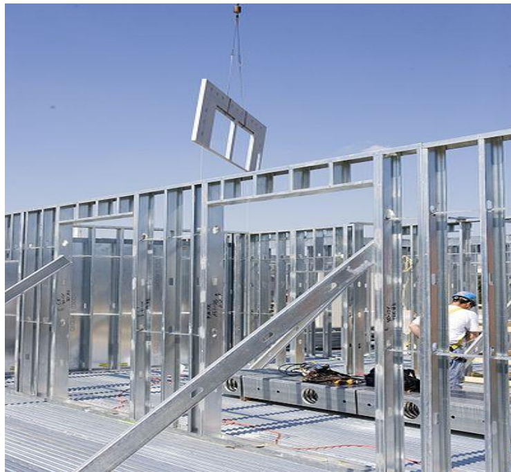
Figura 25: Sistema Constructivo de tipo liviano
