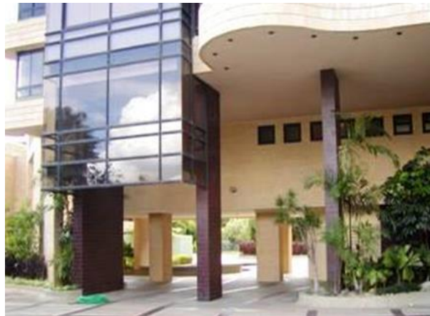
Figura 3. Típica Planta Baja con un primer piso alto y con las columnas que varían significativamente en altura.
