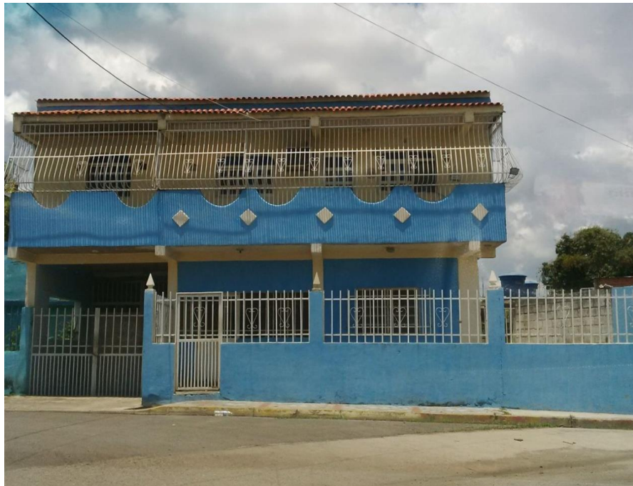
Anexo E. 14. Inspección, código: UR-ZH29-06. Fuente: Elaboración Propia
