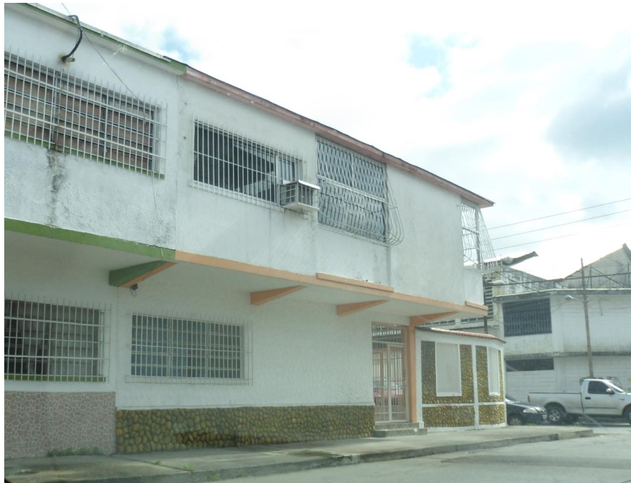
Anexo E. 8. Inspección, código: UR-ZH02-01. Fuente: Elaboración Propia
