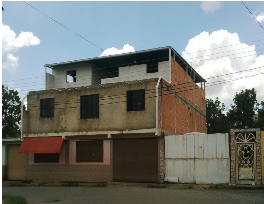
Anexo E. 13. Inspección, código: UR-ZH26-06. Fuente: Elaboración Propia
