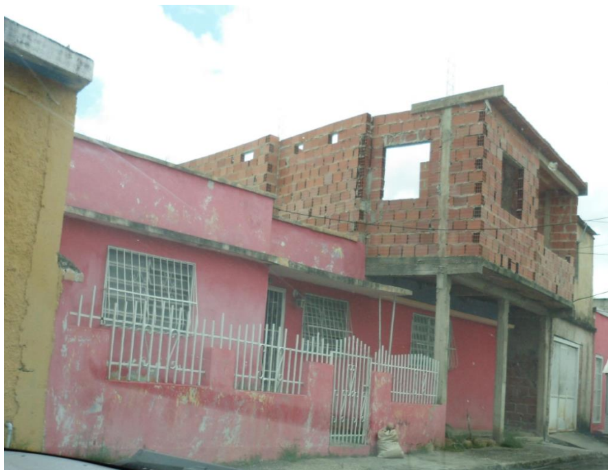
Anexo E. 5. Inspección, código: UR-ZH7-11. Fuente: Elaboración Propia
