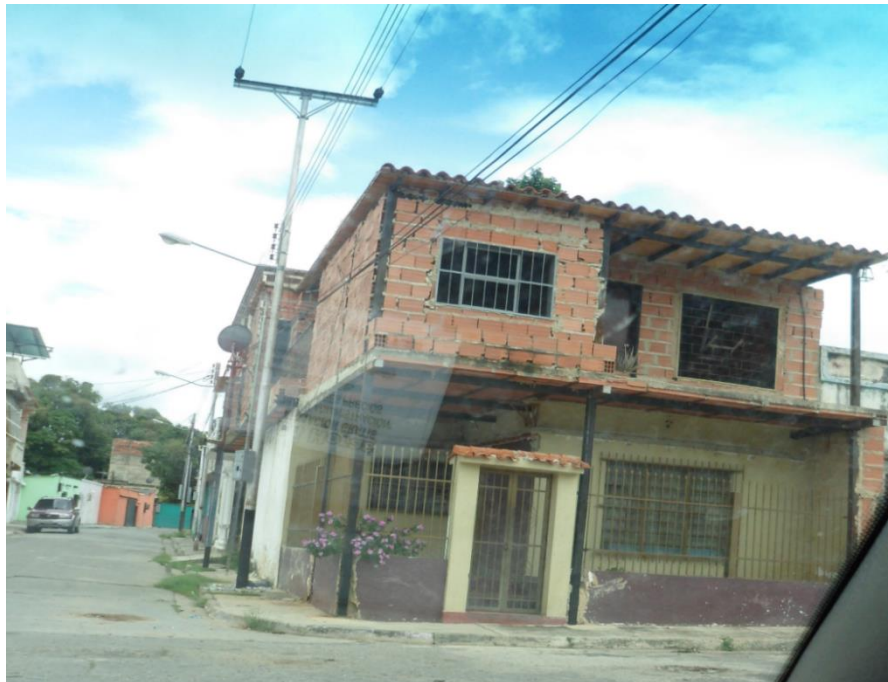
Anexo E. 4. Inspección, código: UR-ZH7-09. Fuente: Elaboración Propia
