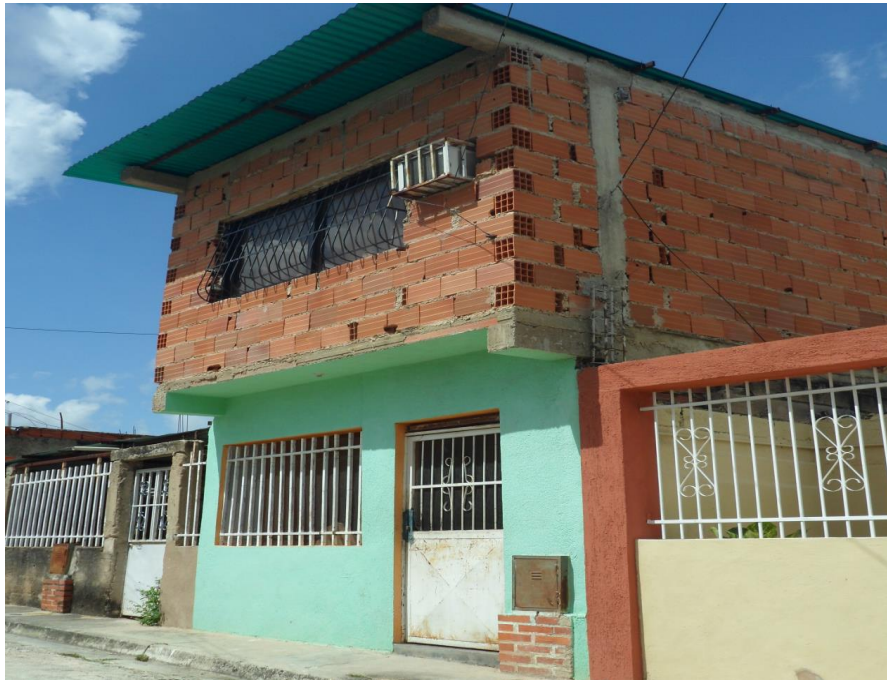
Anexo E. 24. Inspección, código: UR-ZH21-12. Fuente: Elaboración Propia
