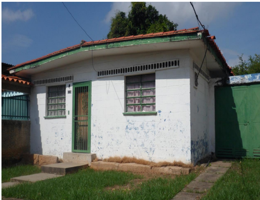
Anexo E. 18. Inspección, código: UR-ZH17-26. Fuente: Elaboración Propia
