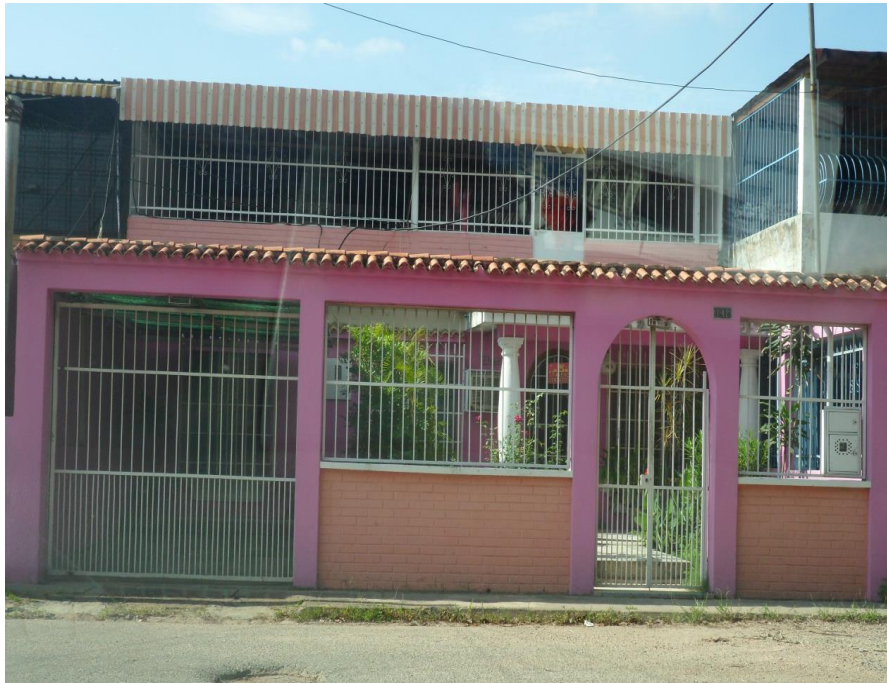
Anexo E. 17. Inspección, código: UR-ZH17-21. Fuente: Elaboración Propia
