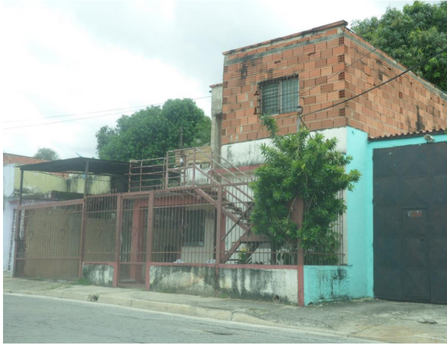
Anexo E. 7. Inspección, código: UR-ZH14-10. Fuente: Elaboración Propia
