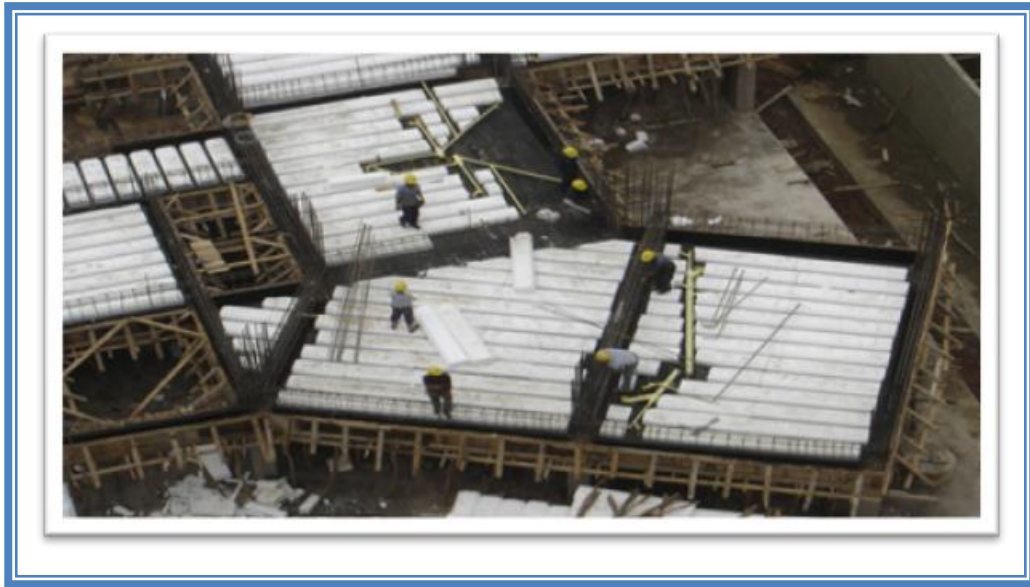
Figura 4. Vista del encofrado de un entrepiso conformado por losas unidireccionales. Fuente: Elaboración propia, (archivos caseros)
