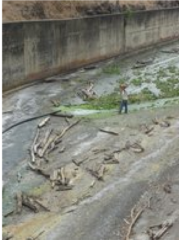
Figura 4.10. Canal de aliviadero de la presa
