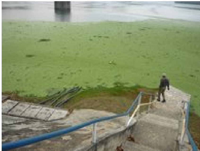
Figura 4.6. Alrededores de la torre-toma selectiva
