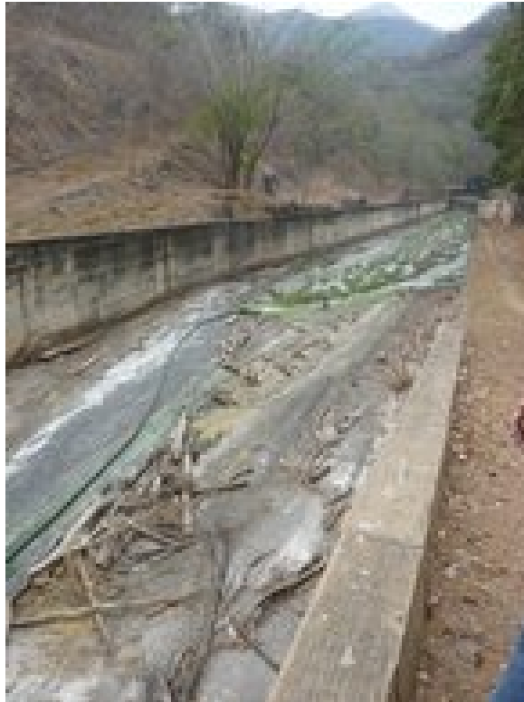
Figura 4.9. Canal de aliviadero de la presa
