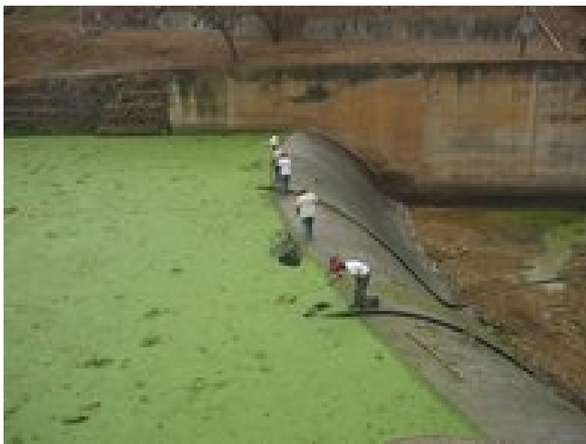
Figura 4.8. Método de extracción de macrófitas utilizado en la actualidad cuando el embalse no se encuentra aliviando
