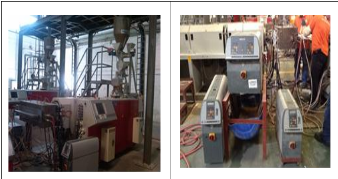
Figura 8. Desplazamientos innecesarios del operador debido a la ubicación de los intercambiadores de calor.
