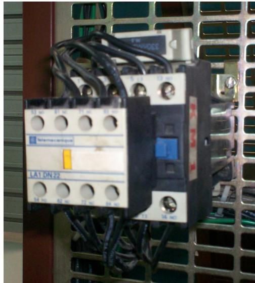
**Figura A-8:** Relé Telemecanique con modulo contactos auxiliares
