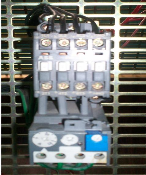
**Figura A-10:** Relés ABB con modulo auxiliar
