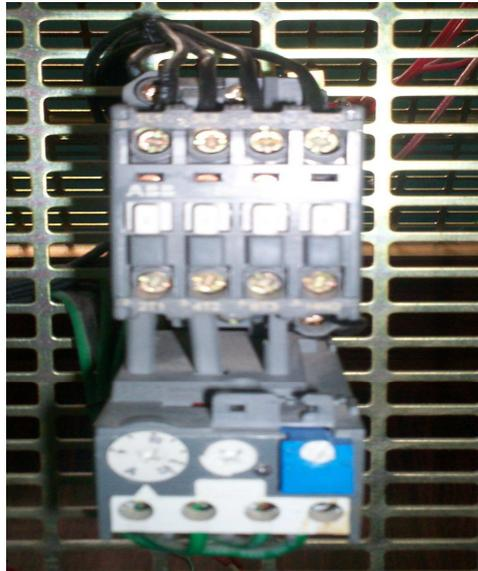
**Figura 4.7:** Relés ABB con modulo auxiliar
