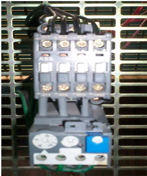
**Figura A-11:** Relés ABB con modulo auxiliar
