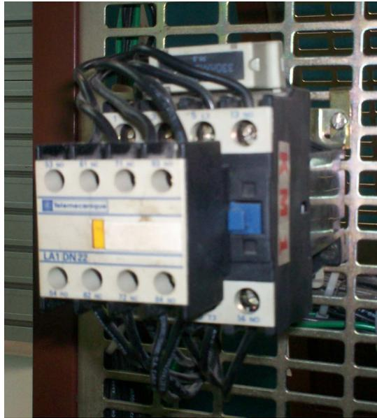
**Figura 4.9:** Relé Telemecanique con modulo contactos auxiliares
