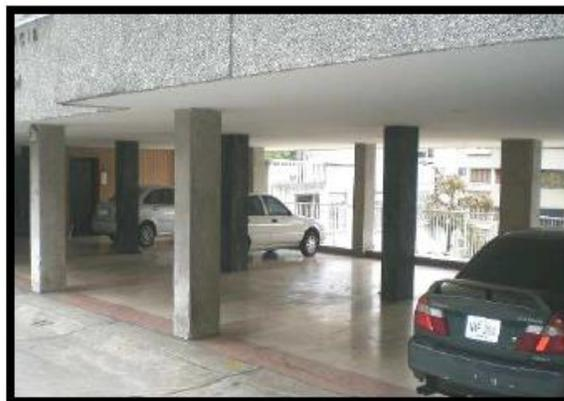
Figura 46. Ausencia de vigas altas en dos direcciones.
