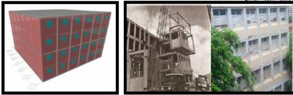
Figura 34. Sistemas pre fabricados a base de grandes paneles o de pórticos (PRE)
