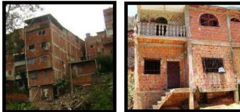
Figura 37. Sistemas mixtos de pórticos y de mampostería de baja calidad de construcción.
