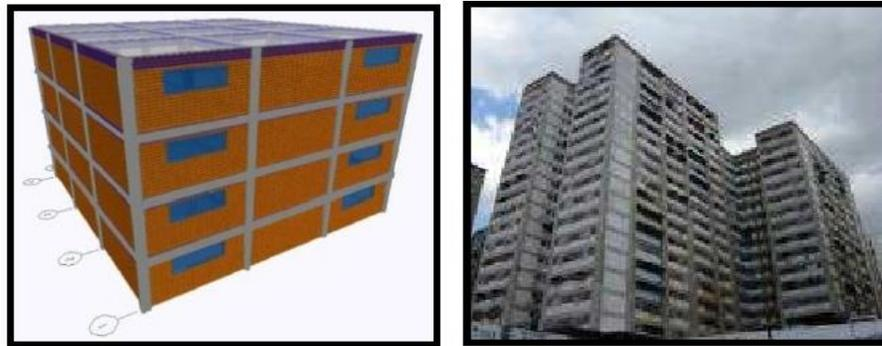
Figura 27. Porticos de concreto armado con paredes de relleno de bloque de arcilla o concreto.
