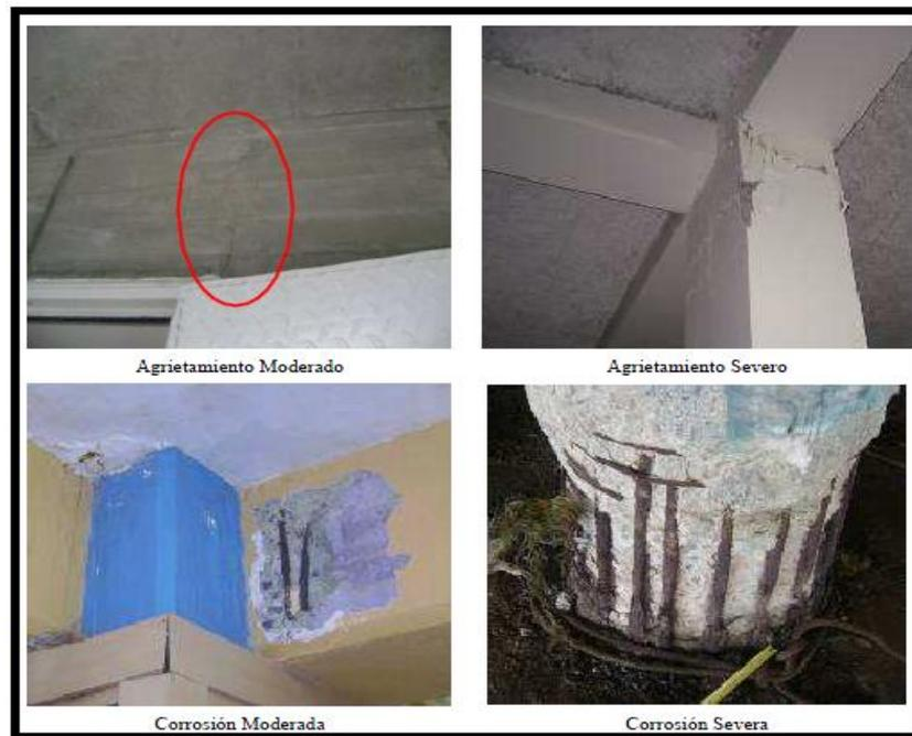
Figura 58. Grado de deterioro, estructuras de concreto armado.
