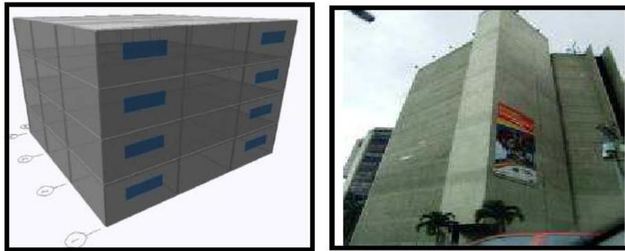
Figura 28. Muros de concreto armado en dos direcciones (MCAD2D).
