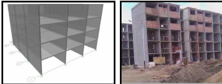
Figura 29. Muros de concreto armado en una sola direccion (MCA1D).
