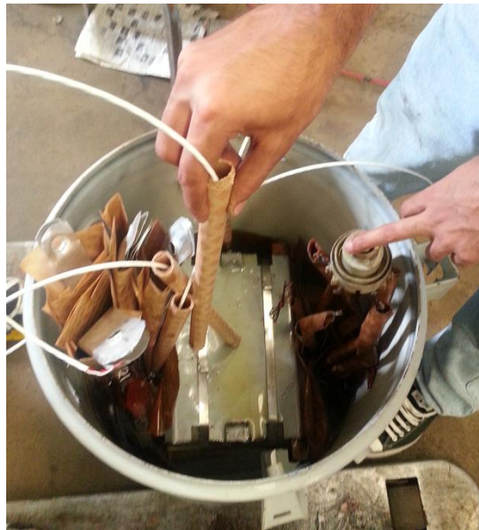
Figura 5.18: Instalación de los sensores. Autores: Cabrera Pedro, Gutiérrez Adrian
