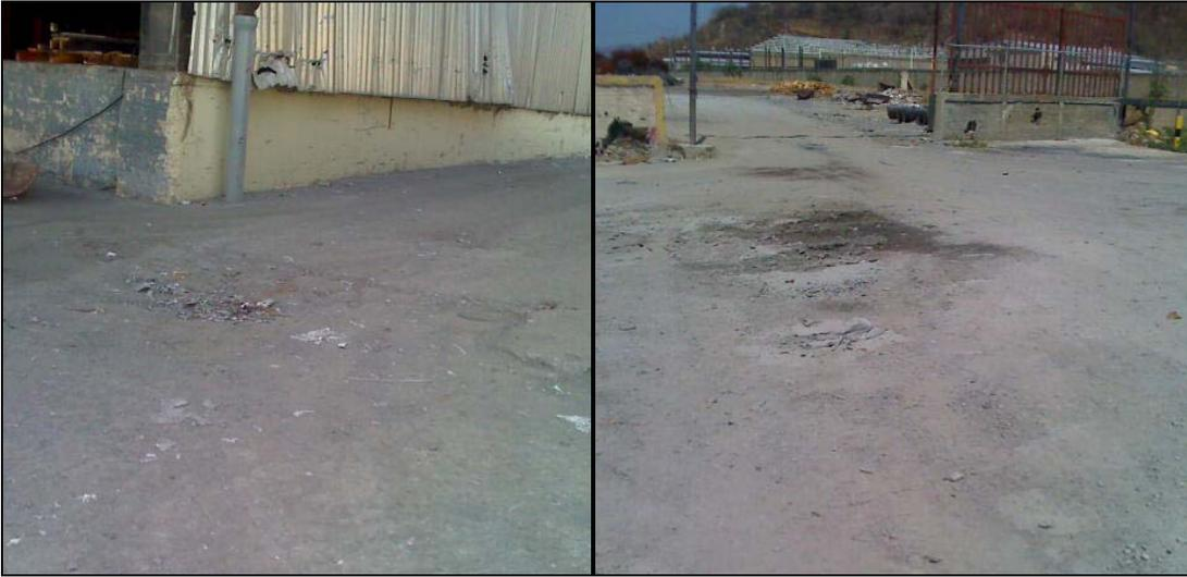
Se muestra en las fotos los baches y desperfectos pronunciados de las rutas utilizadas por los equipos. Usualmente, debido al deterioro de estas vías los materiales livianos o de gran volumen, suelen caerse del montacargas y sufrir daños. Cabe destacar que se manejan por estas vías aproximadamente 120 TM/día de materiales variados entre estos dos equipos, razón por la cual el estado físico de las rutas representa un factor determinante en el deterioro de los equipos de carga.
