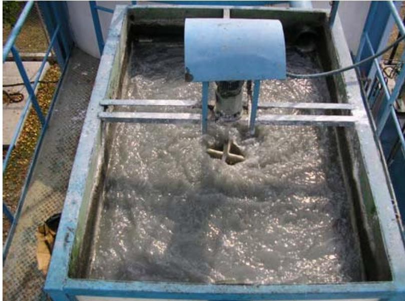
**FIGURA F.3 TANQUE DE PRECIPITACIÓN DE FÓSFORO DE LA P.T.A.R.I.**
