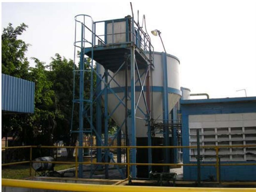
**FIGURA F.2 TANQUES DE TRATAMIENTO FÍSICO-QUÍMICO DE LA P.T.A.R.I. Y SU CORRESPONDIENTE SEDIMENTADOR PRIMARIO**
