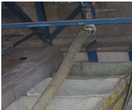
Figura 6.4 Lechos de secados empleados para la recolección de lodos
