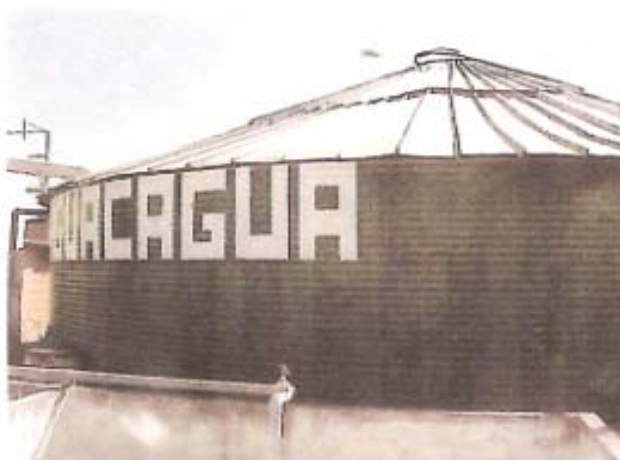
Figura 3.7 Tanque de distribución
