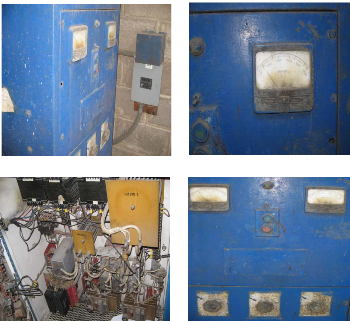
Figura 6.2 Fuente de alimentación utilizada en el proceso de electrocoagulación
