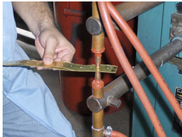
Fig. IV.8 Colocación de la lámina a soldar entre los electrodos. Fuente propia.
