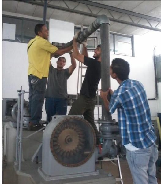
Figura 4.38. Ensamble preliminar del manifold en acero galvanizado del sistema de turbina Francis y turbina Pelton del Laboratorio de Hidráulica, Universidad de Carabobo.
