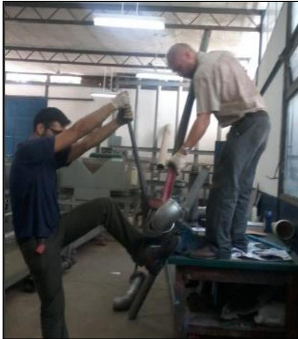
Figura 4.40. Ensamble del tramo principal de tubería del manifold en acero galvanizado del sistema de turbina Francis y turbina Pelton del Laboratorio de Hidráulica, Universidad de Carabobo.
