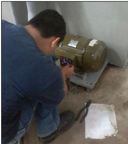
Figura 4.35. Instalación de la conexión eléctrica a la bomba centrífuga de distribución de caudal del sistema de turbina Francis y turbina Pelton del Laboratorio de Hidráulica, Universidad de Carabobo.
