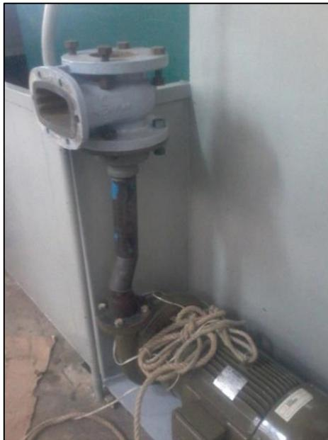
Figura 4.37. Instalación de la tubería de descarga de la bomba centrífuga del sistema de turbina Francis y turbina Pelton del Laboratorio de Hidráulica, Universidad de Carabobo.
