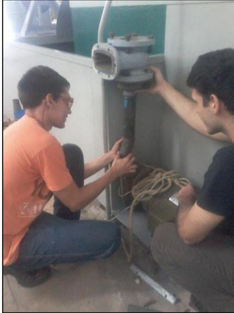
Figura 4.36. Pre ensamble de la tubería de descarga de la bomba centrífuga del sistema de turbina Francis y turbina Pelton del Laboratorio de Hidráulica, Universidad de Carabobo.
