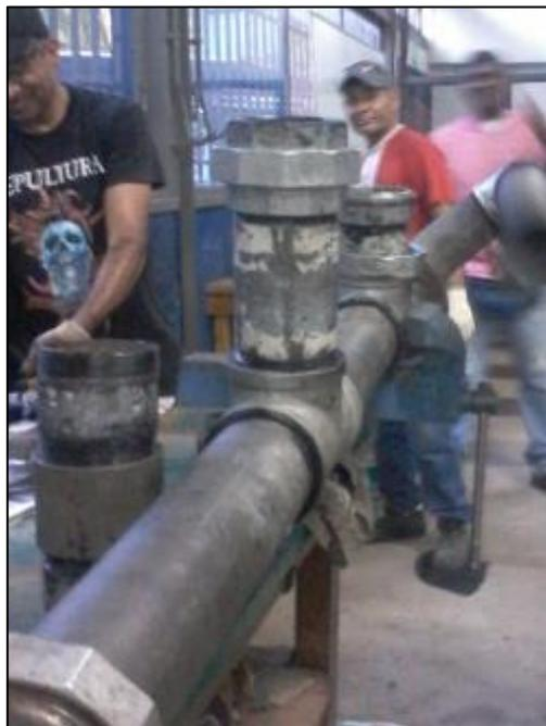
Figura 4.41. Uniones universales, nipples y tees del manifold en acero galvanizado del sistema de turbina Francis y turbina Pelton del Laboratorio de Hidráulica, Universidad de Carabobo.
