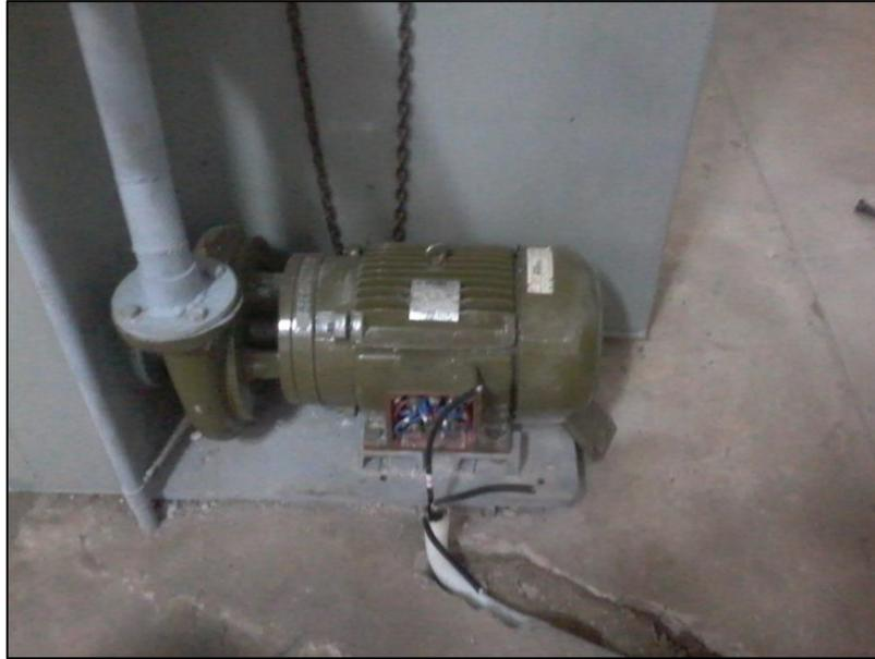
Figura 4.42. Bomba centrífuga del subsistema de distribución instalada en su ubicación final, con soportes inferiores, conexión bridada e instalación eléctrica. Sistema de turbina Francis y turbina Pelton del Laboratorio de Hidráulica, Universidad de Carabobo.
