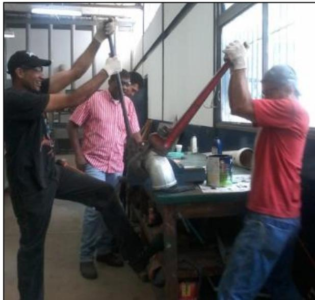
Figura 4.39. Ensamble del codo de la turbina Pelton en el manifold de acero galvanizado del sistema de turbina Francis y turbina Pelton del Laboratorio de Hidráulica, Universidad de Carabobo.
