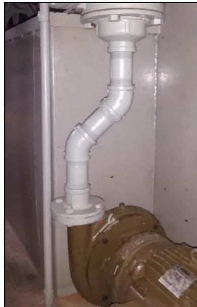
Figura 4.43. Tubería de descarga de la bomba centrífuga de distribución de caudal del sistema de turbina Francis y turbina Pelton del Laboratorio de Hidráulica, Universidad de Carabobo.
