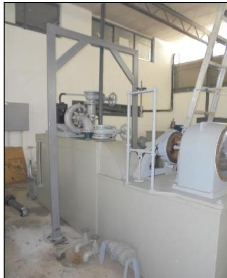
Figura 4.45. Estructura de soporte del manifold en acero galvanizado instalado y fijado a los cimientos del Laboratorio de Hidráulica, Universidad de Carabobo.
