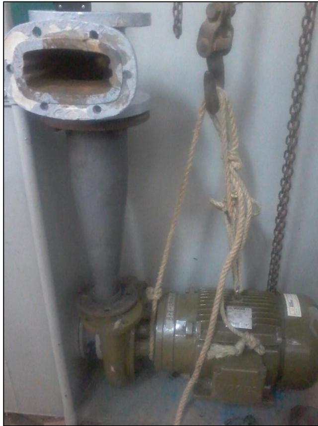
Figura 4.12. Desalineación entre brida de descarga de la bomba centrífuga y tubería de descarga en PVC del sistema de turbina Francis y turbina Pelton del Laboratorio de Hidráulica, Universidad de Carabobo.
