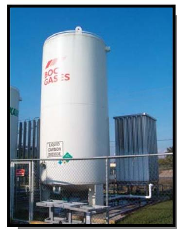
**Figura 3.2. Tanque almacenador de CO<sub>2</sub> de BOC GASES, C.A. (Fuente: Propia)**
