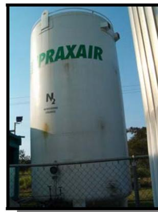
**Figura 6.1. Tanque almacenador de N<sub>2</sub> (Fuente: Propia)**
