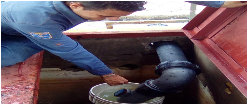
Figura 25. Medición de Caudal Encendido de la Planta Automático Protinal Proagro Planta Embutidos UTM (614668 E; 1126507 N). Elevación: 444 msnm. Fecha: 10/04/2017 Zona Industrial, Municipio San Diego, Estado Carabobo
