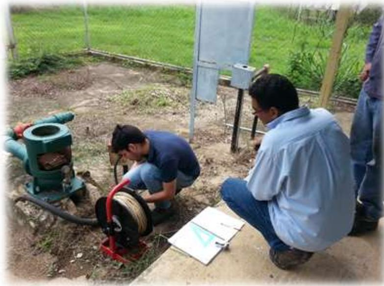
**Figura N° 8. Medición de niveles para prueba de caudal variable en C.A. Venezolana de Pigmento en compañía de trabajadores de la empresa. Coordenadas UTM 613723.86E; 1127425.32N. Zona Industrial Castillito, Municipio San Diego, Estado Carabobo. Fecha 11/05/2016**
