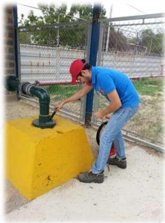
**Figura N° 6. Medición de Niveles en el pozo N°13 de ProAgro. Coordenadas UTM 614670E; 1126508N. Zona Industrial Castillito, Municipio San Diego, Estado Carabobo. Fecha: 18/11/2015.**
