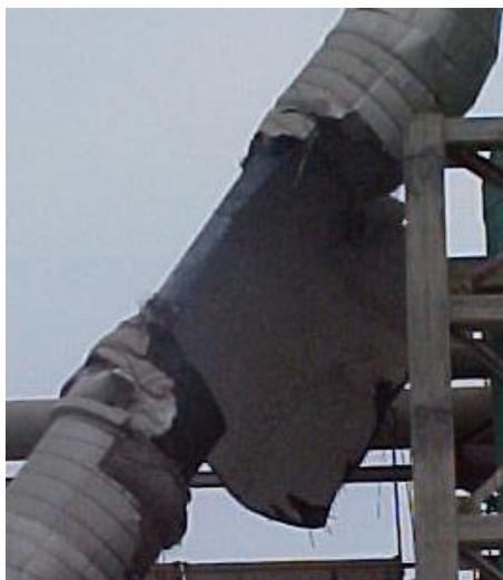
Figura N°1.- Falla catastrófica en línea de tope de Regenerador FCC [3]
